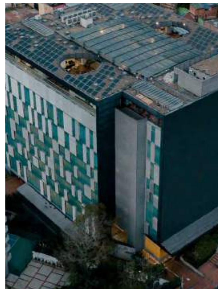
Paneles Solares en el SD. Fotografía: Felipe Cazares. Universidad de los Andes
